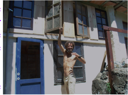
Wachesar a posé les fenêtres de la chambre "Pervenche"
